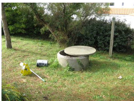
Illustration 51 : Exemple de puits busé ayant servi à la caractérisation de la nappe des dunes
