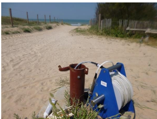
Illustration 10 : piézomètre PG1 lors de sa 1ère installation en janvier 2017.
